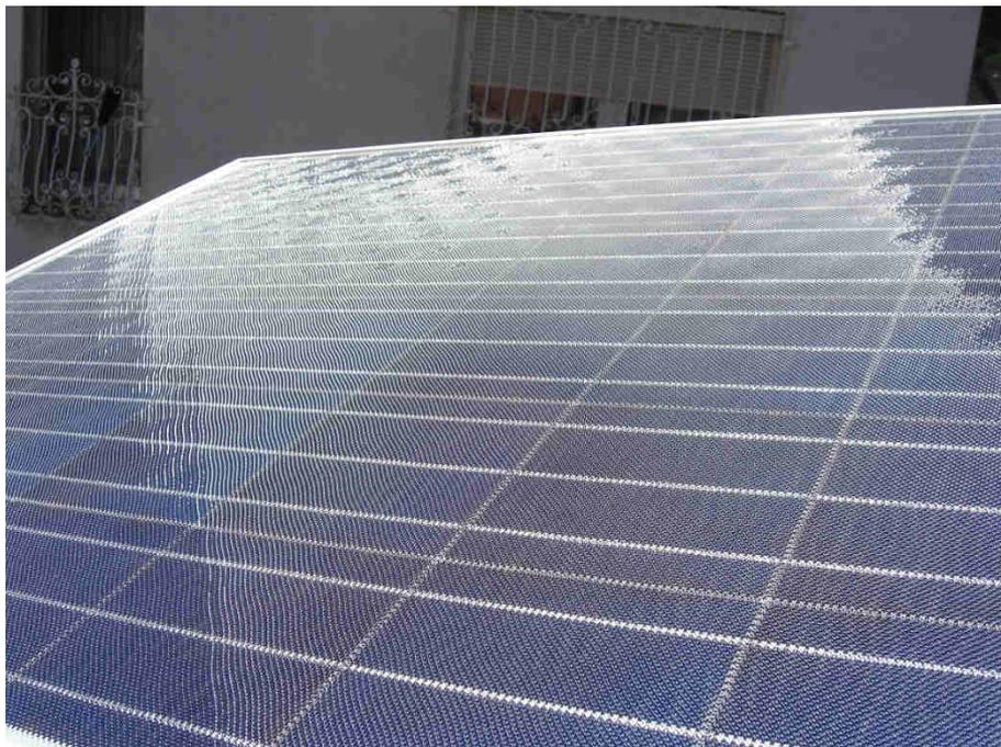
steiler Einstrahlwinkel, steiler Blickwinkel, maximale Reflexleuchtdichte ca.  $20.000 \text{ cd/m}^2$
